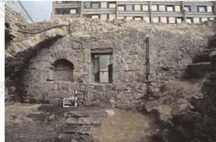
Barocke Kellerwand mit Weltkriegsdurchbruch
