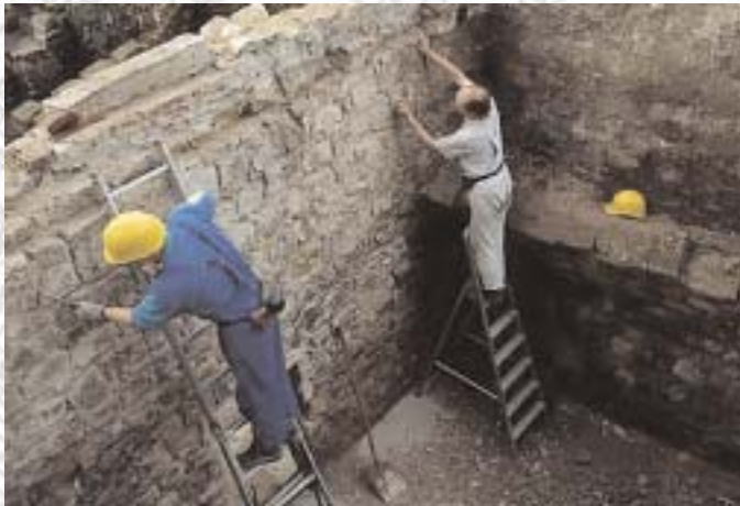
Um das Mauergefüge beurteilen zu können, wird der Putz abgeschlagen.
