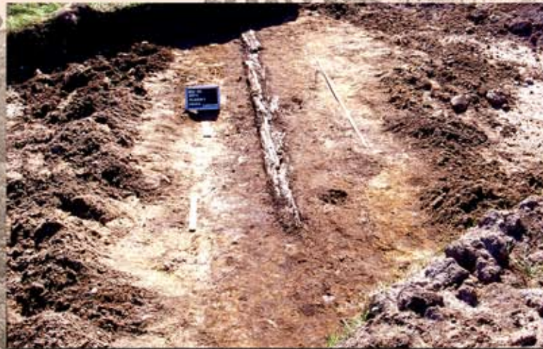
Abb 21: Die freigelegte Holzwasserleitung verläuft quer über die Straßenrasse
