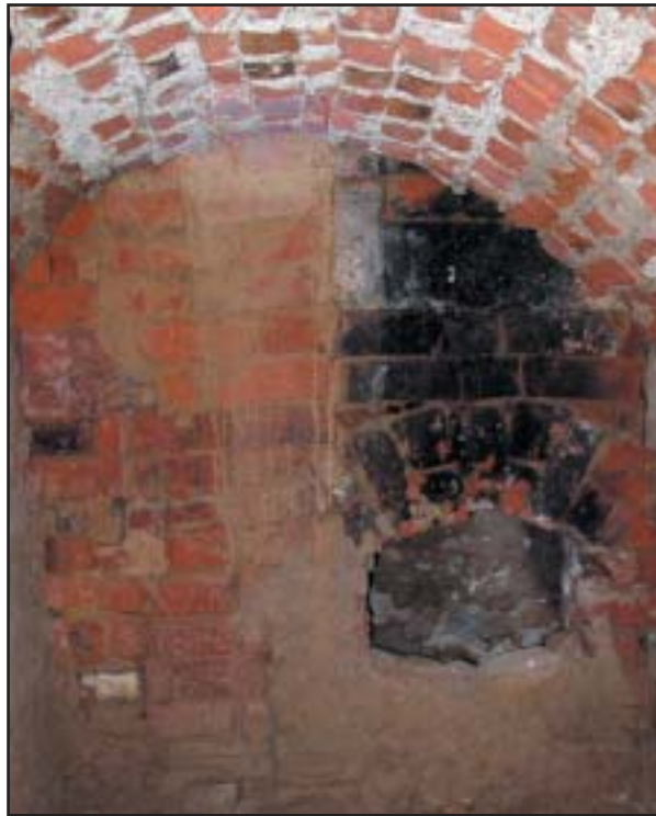
Feuerungswand der Steinofenluftheizung.
