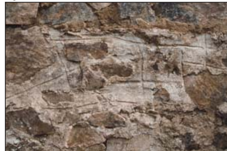
Fugenstriche an innerer Stadtmauer.
