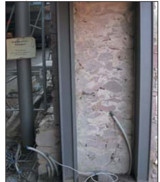
Die aufgesägte äußere Stadtmauer.
