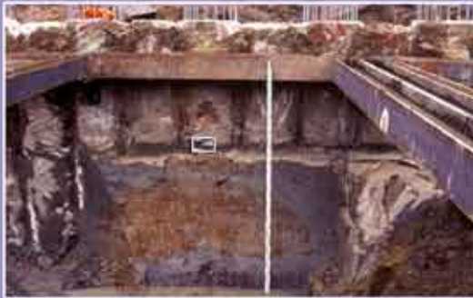
Abb. 9 (oben): Der hohe Grundwasserstand sorgte gelegentlich für wassergefüllte Baugruben.
