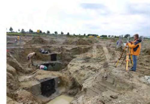
Abb. 16: Vermessungsarbeiten an den Befunden 170 und 317
