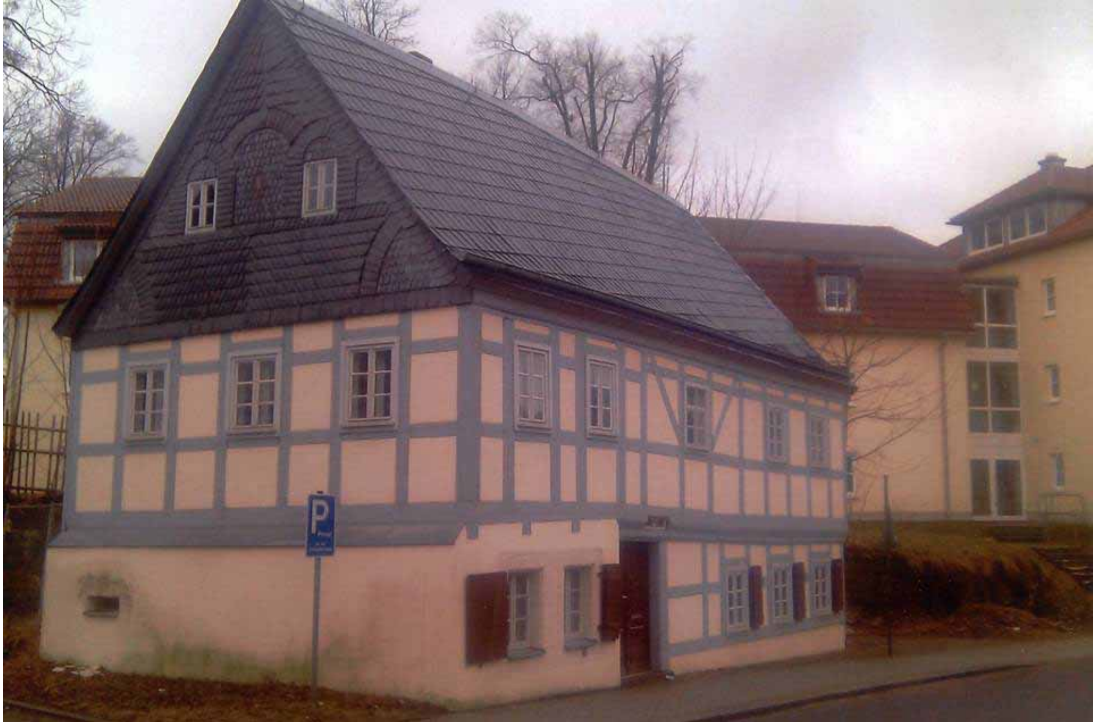
Sebnitz Fachwerkhaus: erhalten und saniert
