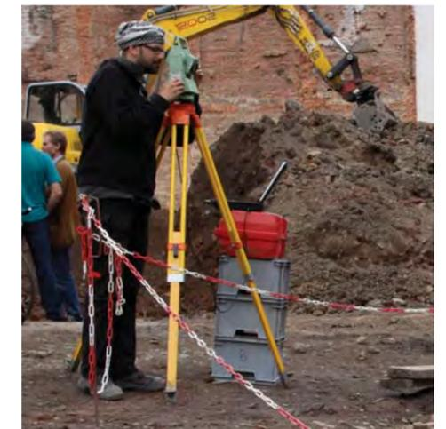
Einmessen mit dem Tachymeter
