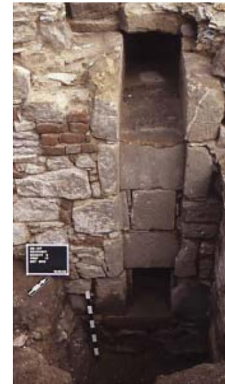
Abb. 8. Durchlass und Überlauf eines Stauwehres unter der Frauentorbrücke.
