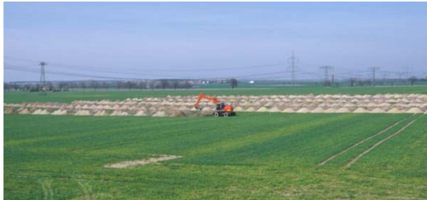
Streifen für Streifen. In einem ersten Grabungsabschnitt wurde der Oberboden in ca. 4 m breiten Streifen maschinell abgetragen.
