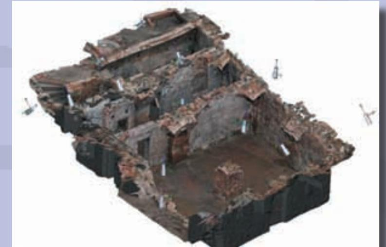
Abb. 39: Königsplatz-5. Eingefärbte Punktwolke mit Scannerstandorten. Deutlich erkennbar die Pfeilerstellung und eine spätere Zusetzung zur Unterteilung in zwei Räume.
