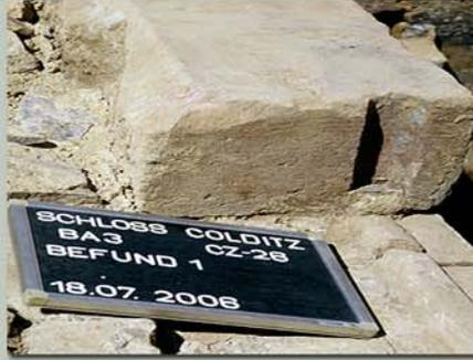
Die Quader des Beckens sind Nut-Feder gesetzt (Abb. links) und z. T. geklammert. Dass diese noch heute sichtbaren Eisenklammern (Abb. rechts) der ursprünglichen Bautechnik entsprechen, zeigen verschiedene Handwerkerrechnungen über Reparaturarbeiten aus dem 17. Jahrhundert.
