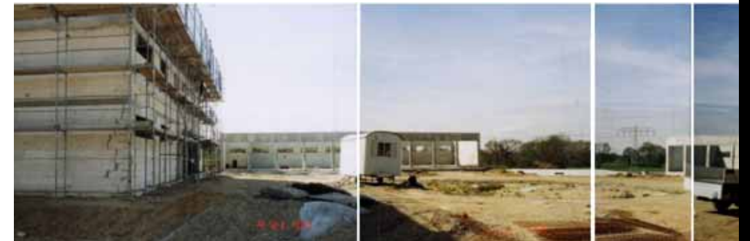
Blick in die Baustelle.
