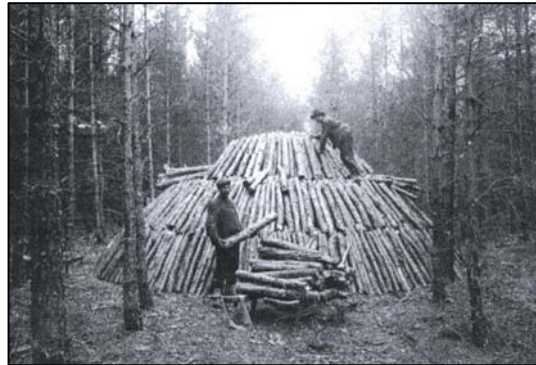
Köhler bei der Errichtung eines Platzmeilers (Hillmer 1999)
