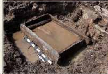
1907/08 während der Talperrensaniierung gelagertes Füllrohr im Füllgraben
